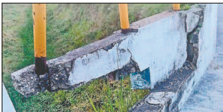
Hay riesgo de caídas ante el barandal roto y las varillas expuestas.
