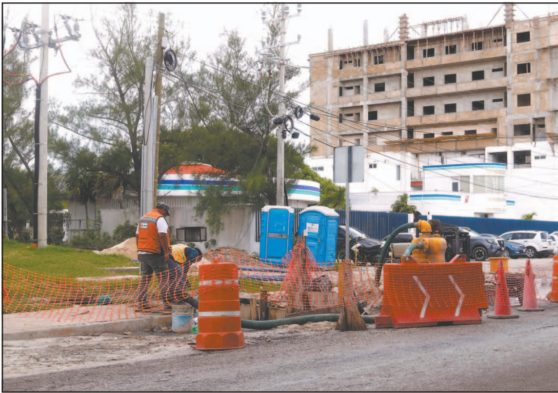
Eliminan tubería que vertía líquidos residuales y acoplan nueva línea al sistema de alcantarillado. (R. Flores)
