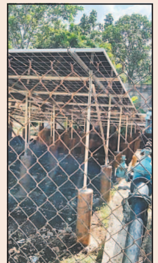
Fueron instalados paneles solares para las bombas.
