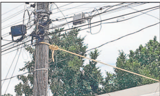
UNA estructura de madera, con cables de alta tensión y que representa riesgo para la población, fue atada a un árbol como "remedio temporal".- (E. Caamal)
