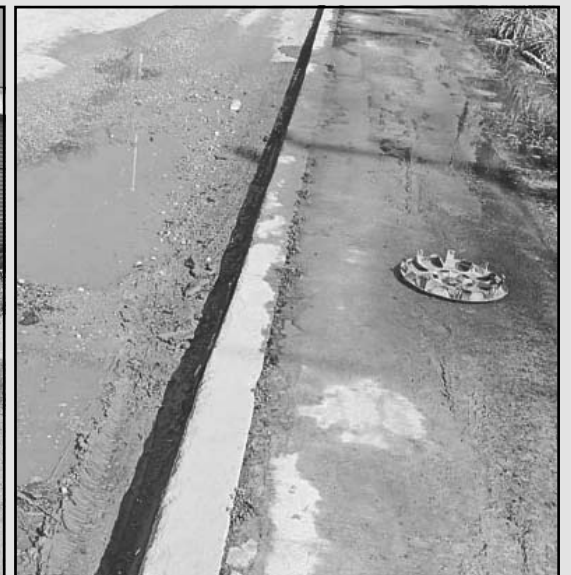
La carpeta asfáltica tiene baches y hay agua encharcada con verdín sobre la banqueta. (Juan V.)
