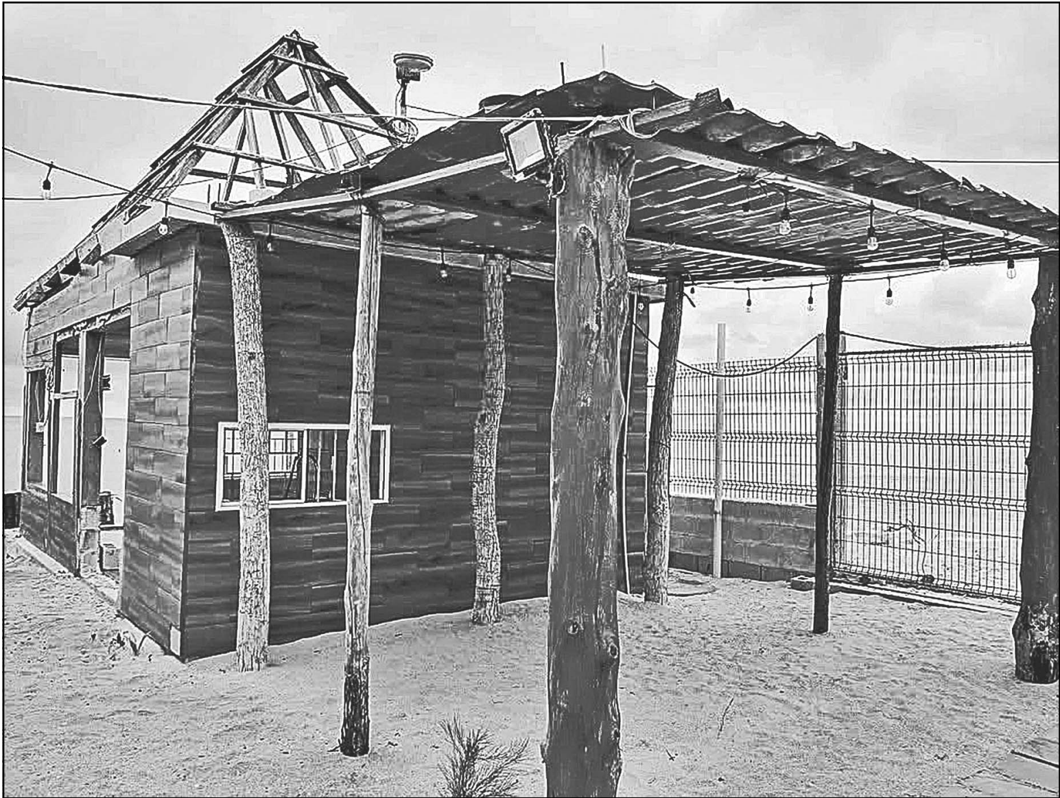
La casa es de 27.88 metros cuadrados con baño y fregadero, construida con paredes de block y loseta, sin techo y con estructura de madera.
