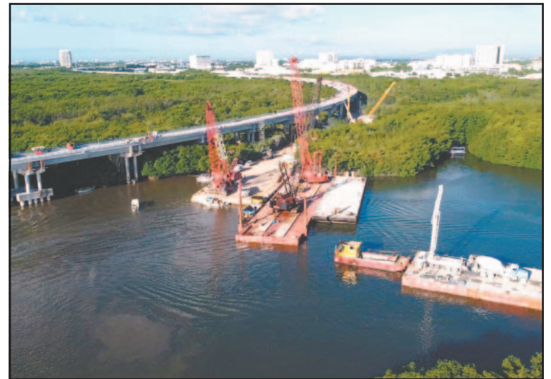
La construcción de pilas de cimentación ya concluyó. (Fotos PorEsto!)
