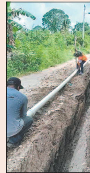
Reemplazan las tuberías obsoletas por nuevas.
