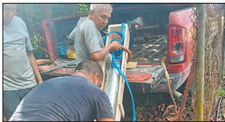
Instalaron una nueva bomba sumergible de 50 caballos de fuerza.
