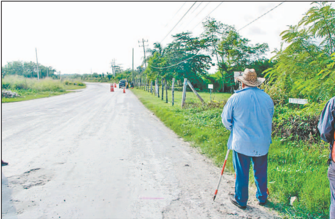
Los trabajadores pidieron que se formen un Comité Ciudadano para que supervise los trabajos. (Juan V.)
