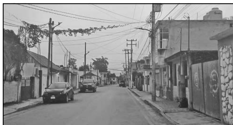
Los colonos advierten riesgo de cortos circuitos. (Joaquín Guevara)
