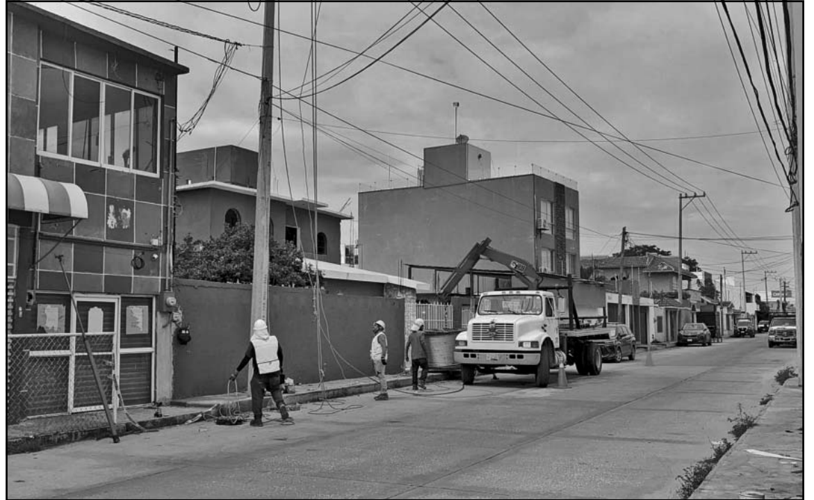
Si bien algunos aplauden que la paraestatal dé mantenimiento a su infraestructura, hay quienes dudan.
