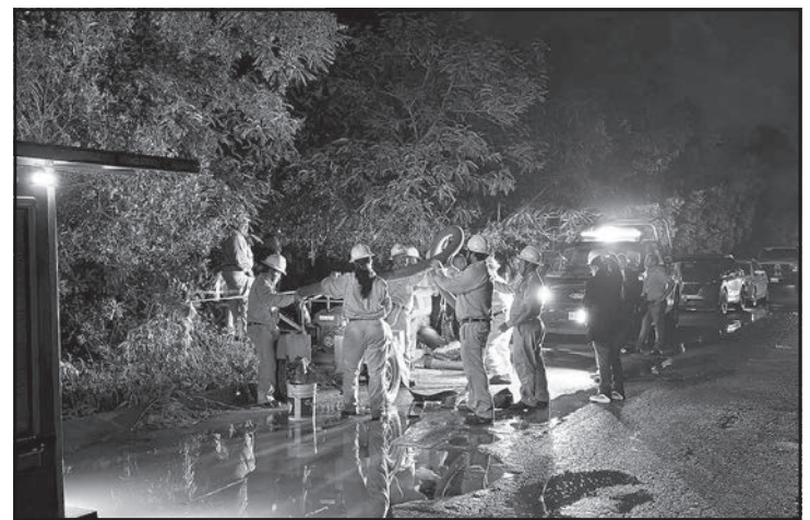
Un sujeto habría tratado de hurtar cables y se electrocutó. (L. Chacón)
