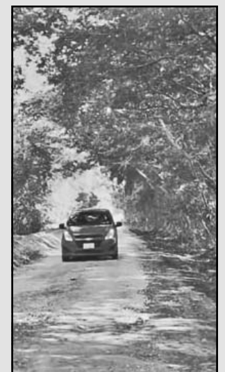
Los trabajos iniciaron en las partes más afectadas.
