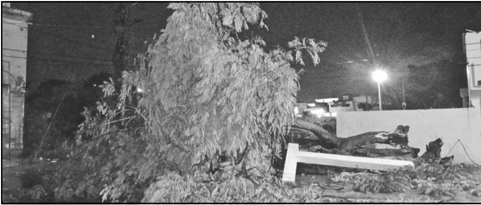
Ramas caídas sobre líneas de alta tensión generan riesgo para peatones y vehículos.
