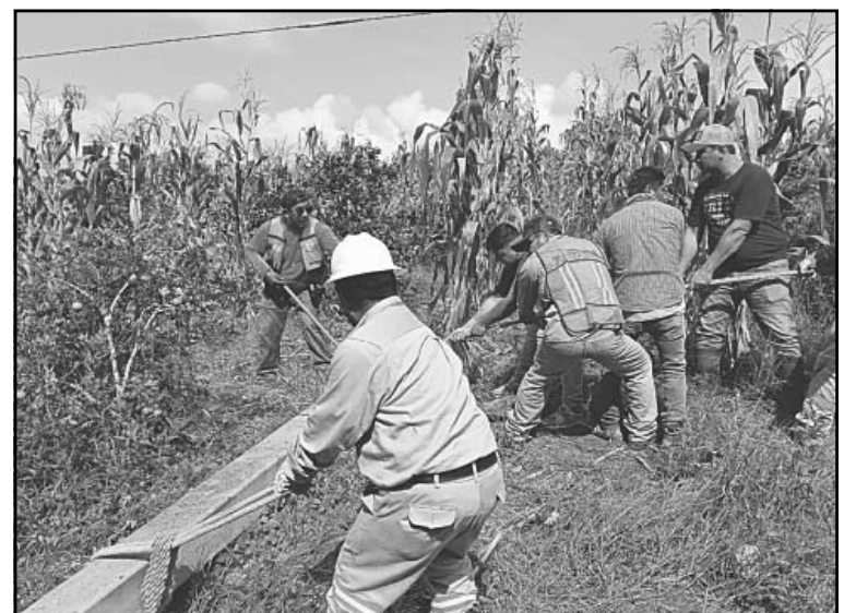
Trabajadores de la CFE restablecieron el servicio eléctrico en un 98.7%.
