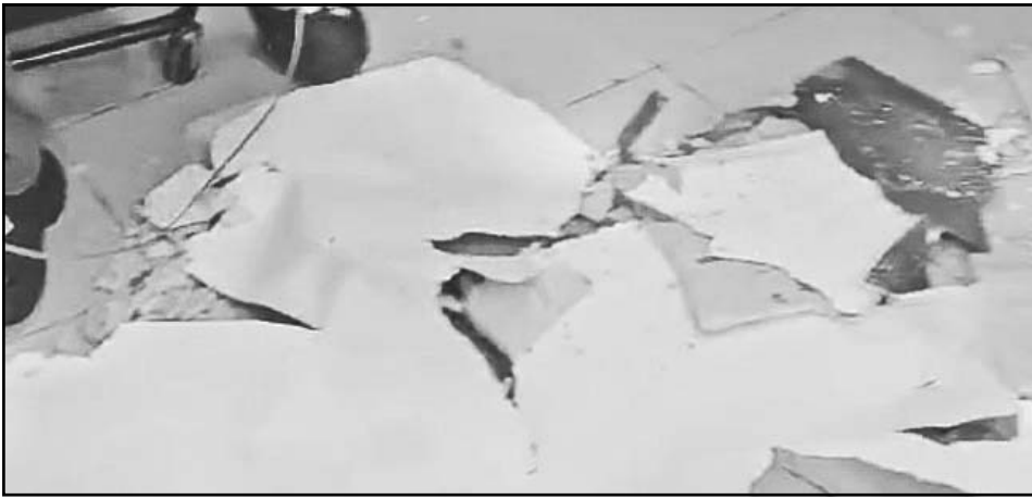
Los daños fueron atribuidos a la humedad acumulada y a la falta de mantenimiento.
