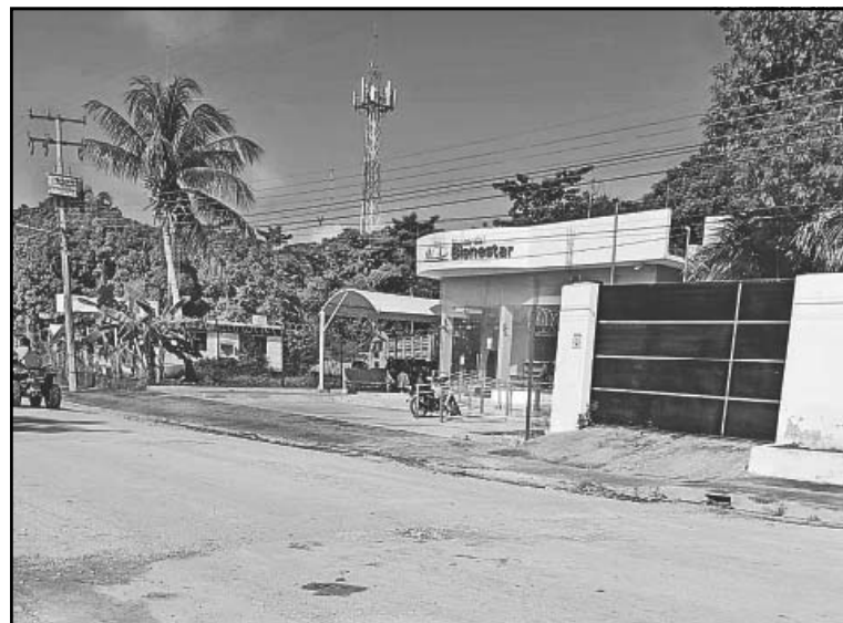
La "practicaja" sigue fuera de operación sin fecha de reparación.
