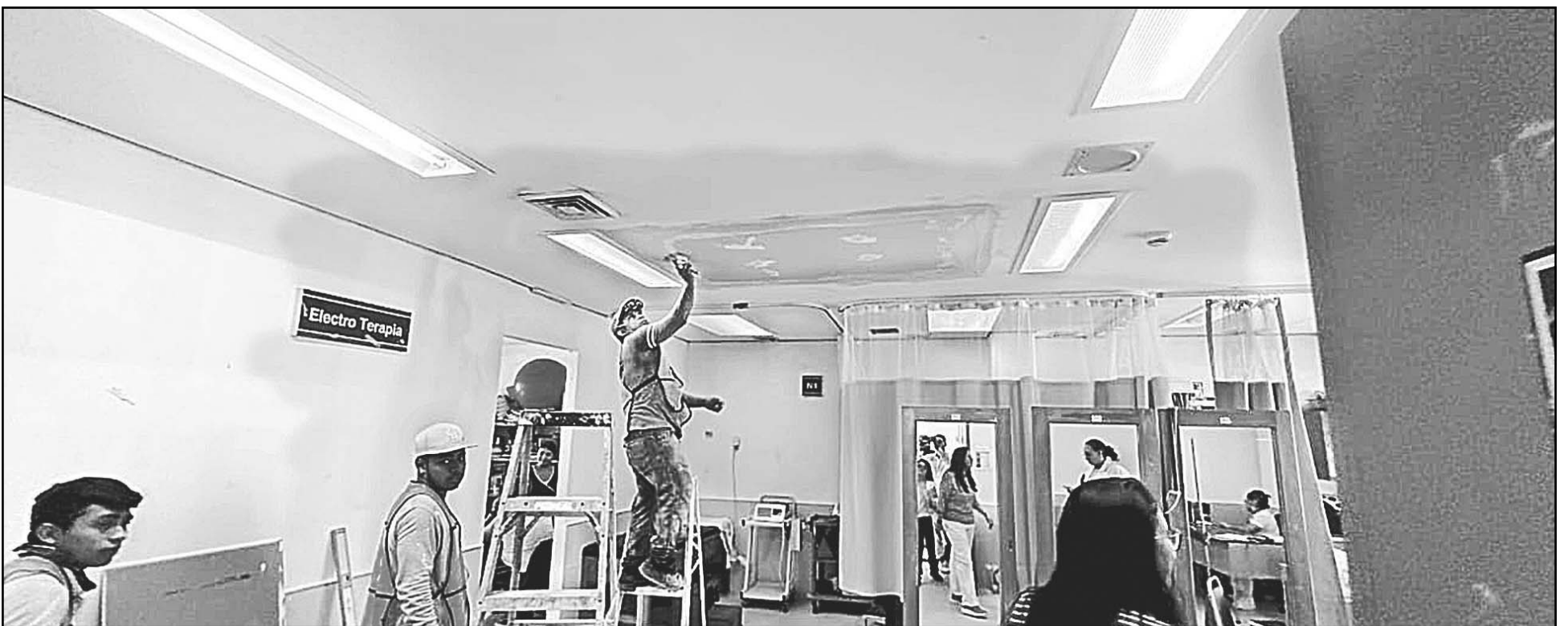
Personal del hospital informó sobre las causas del imprevisto y aseguró que ya se realizan los trabajos de reparación para garantizar la seguridad en la UMF 12. (P. Prado)
