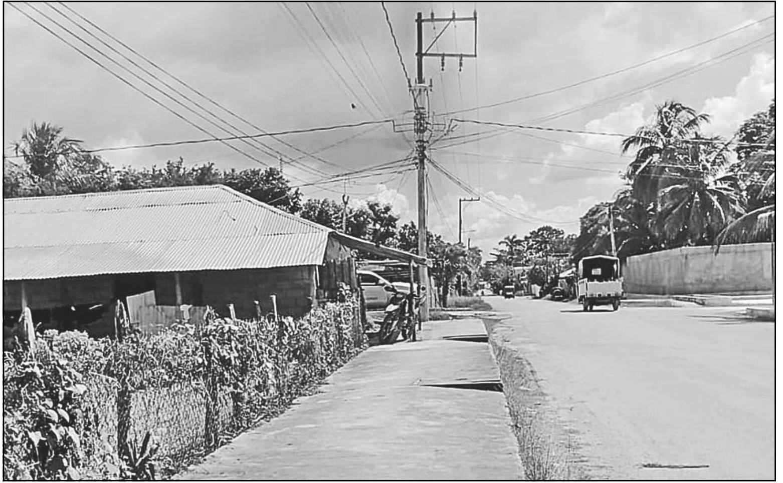
La situación ha causado el hartazgo entre los vecinos, quienes piden la rehabilitación integral de la red principal de suministro. (Juan V.)
