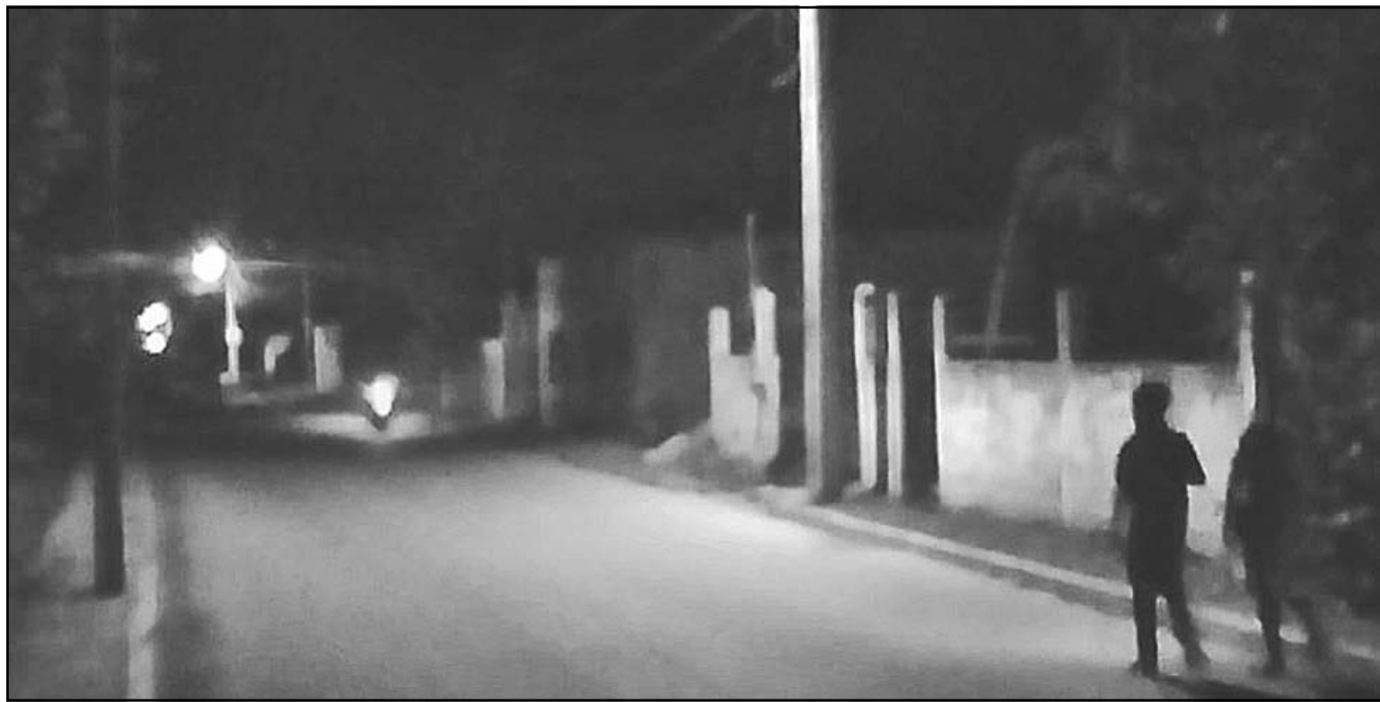
Tramos de la calle Benjamín Romero permanecen sin iluminación, afectando la movilidad de quienes regresan tarde a casa. (Pedro Díaz)
