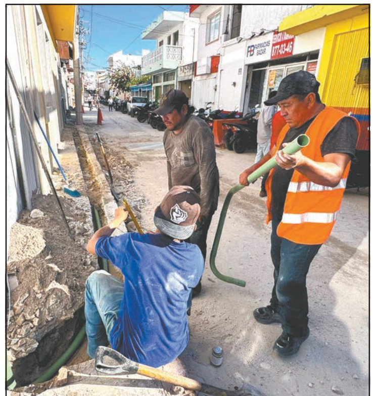
Trabajadores instalan nuevas acometidas domiciliarias. (O. López)
