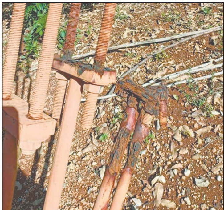
Puntos de anclaje de la estructura están muy oxidados. (Lusio Kauil)
