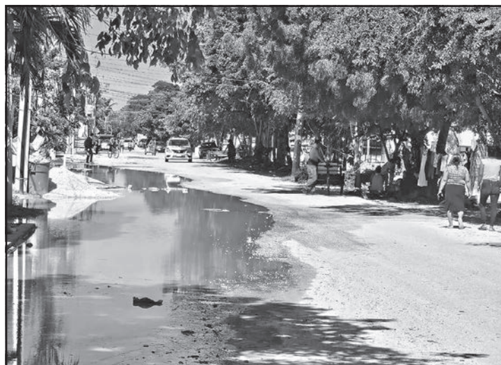
Quejosos apuntaron malos olores por filtración de aguas negras.
