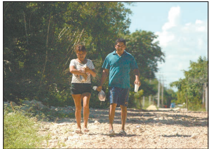
La gente cooperó para reinstalar el cableado eléctrico que se dañó.
