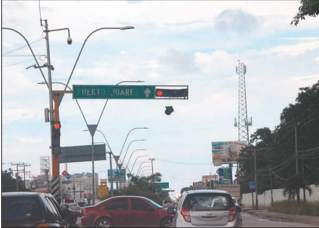
Una lámpara de control vehicular en la avenida José López Portillo se encuentra a punto de caer. (Liza Vera)
