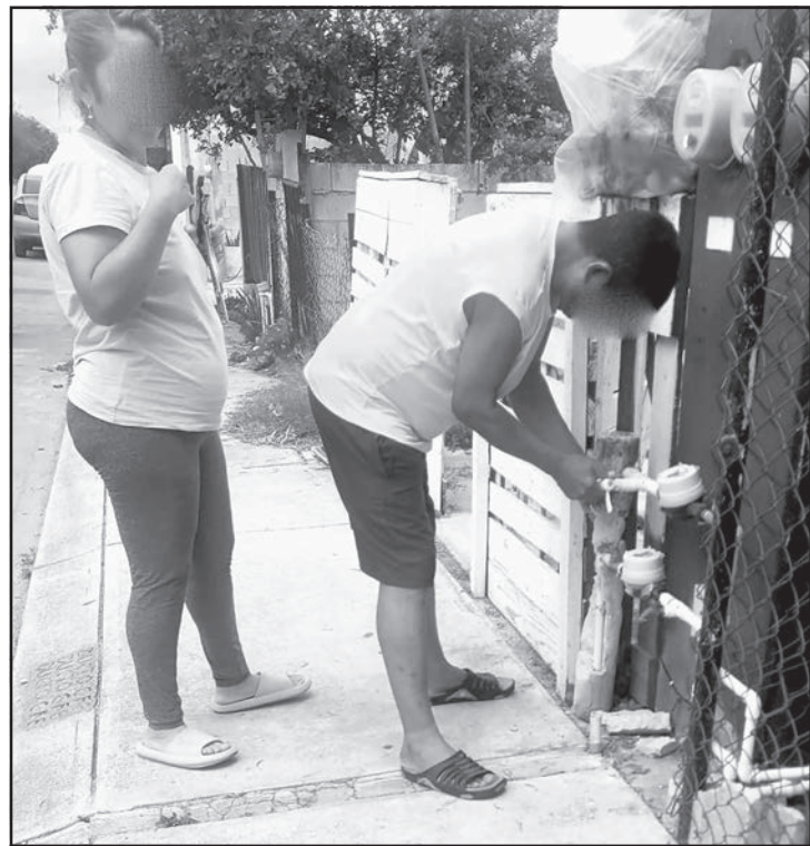
Residentes indicaron que no hay mantenimiento a medidores. (L. Vera)
