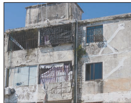
BASES corroídas y varillas expuestas son evidentes en construcciones de la Supermanzana 77.- (M. Hernández)
