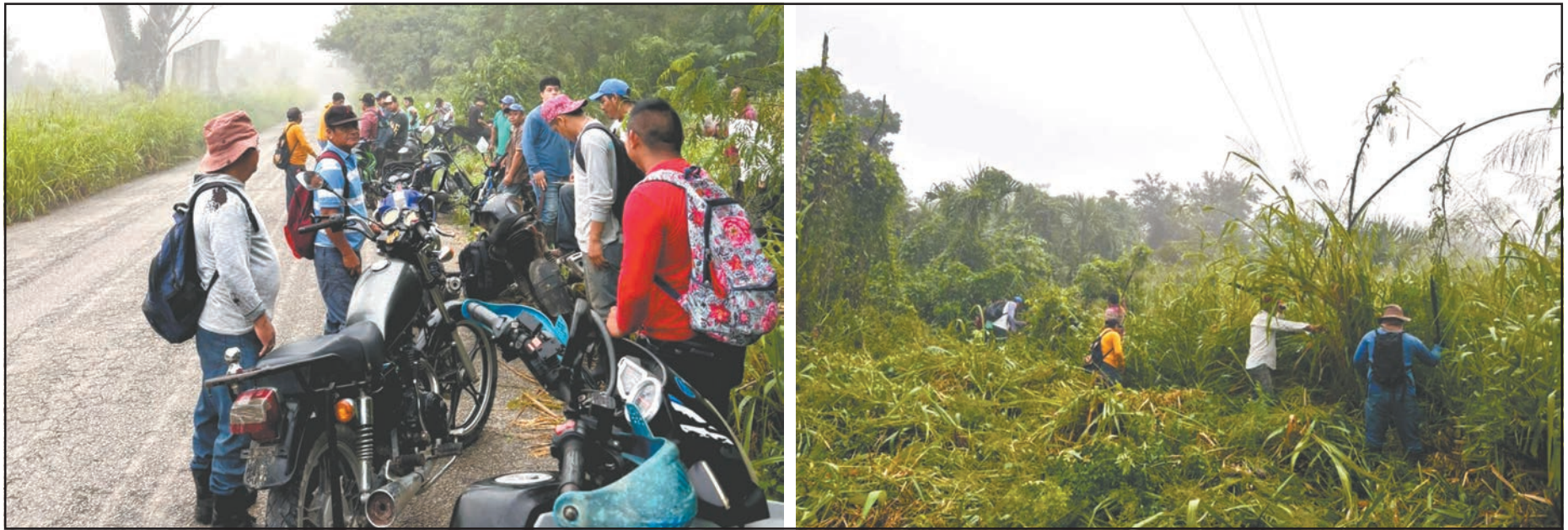
Ejidatarios de Altos de Sevilla trabajan en la limpieza de líneas eléctricas para intentar mantener el suministro y reducir las fallas que afectan a toda la zona rural. (Fotos PorEsto!)
