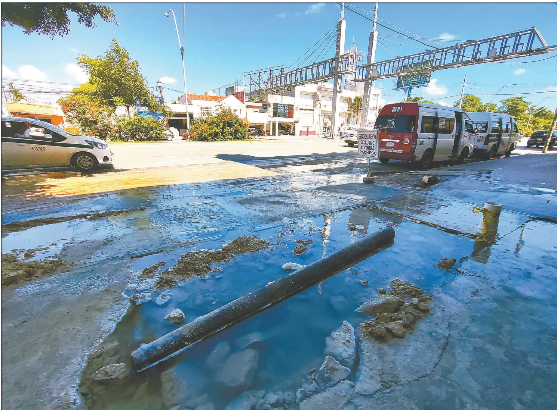
Transportistas que operan en el primer cuadro del destino alertaron del peligro derivado de varias filtraciones de líquido, pues pueden causar accidentes fatales. (Mario Hernández)
