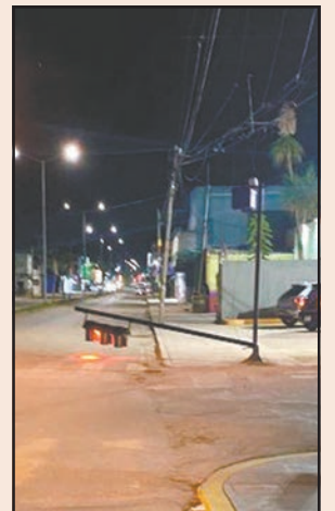
Semáforo quedó dañado en la madrugada. (L. Kauil)
