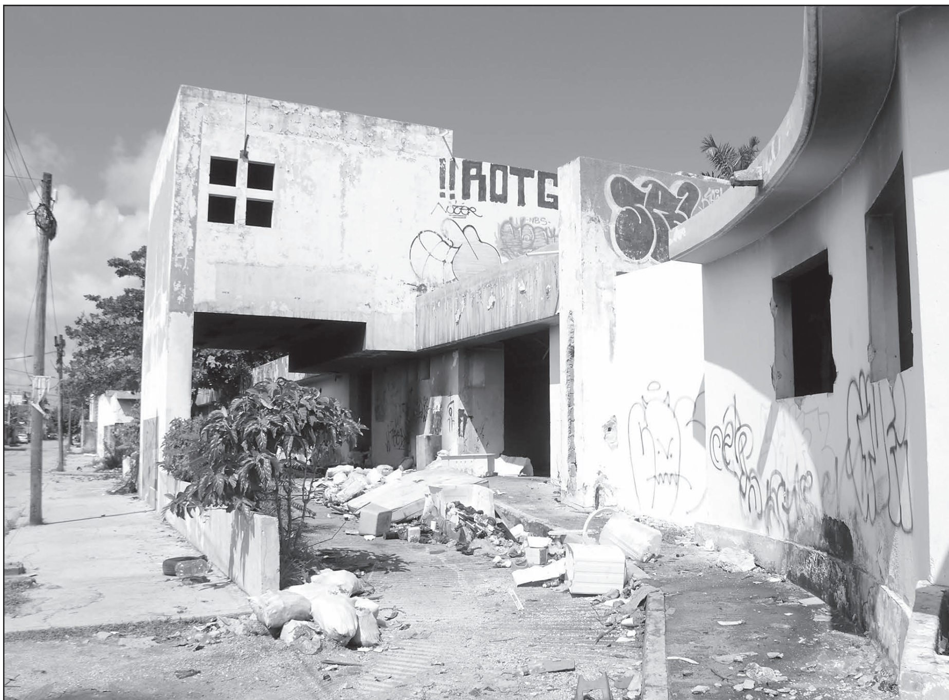
Edificaciones como el antiguo hospital general y la tienda del ISSSTE representan focos de inseguridad, señalado por habitantes de las Sm. 68, 93 y 94, sin lograr respuesta. (E. Romero)
