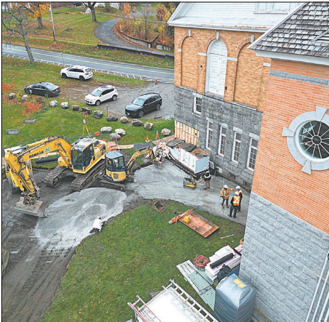
Excavadoras trabajan arduamente en el sitio para devolver la entrada al recinto binacional. (POR ESTO!)
