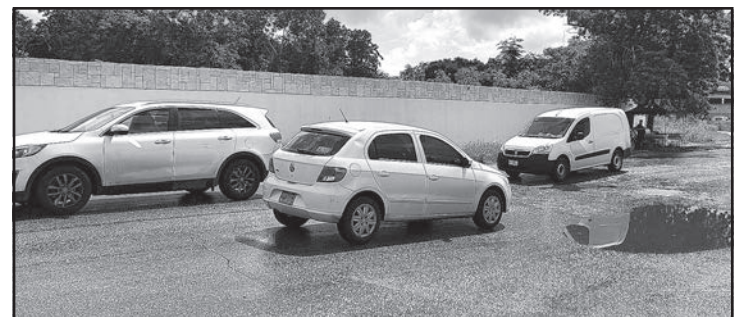
Ciudadanos temen colapse un tramo carretero. (Mario Hernández)
