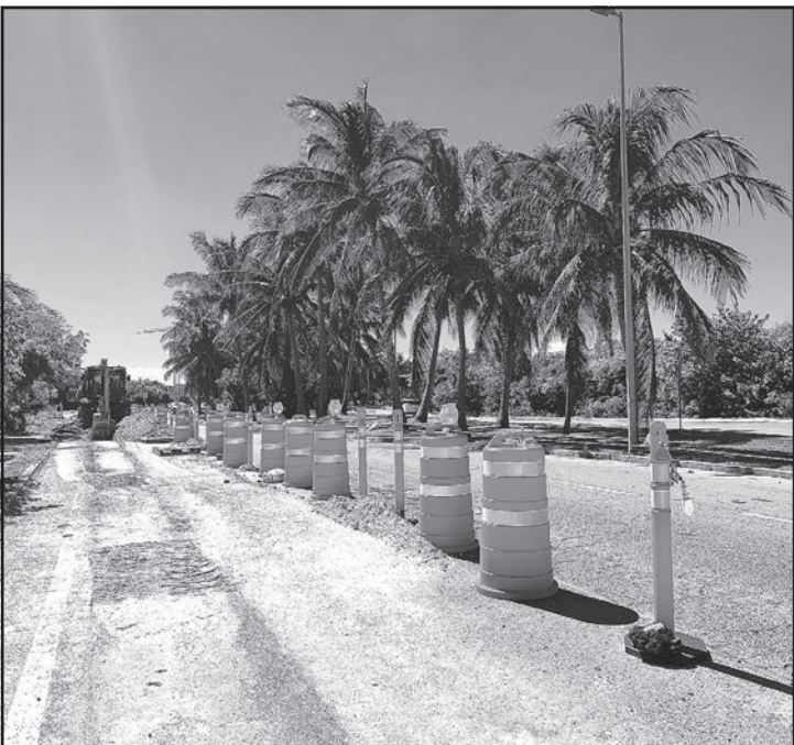
Una repavimentación en el bulevar Kukulcán será de noche. (M. Hernández)
