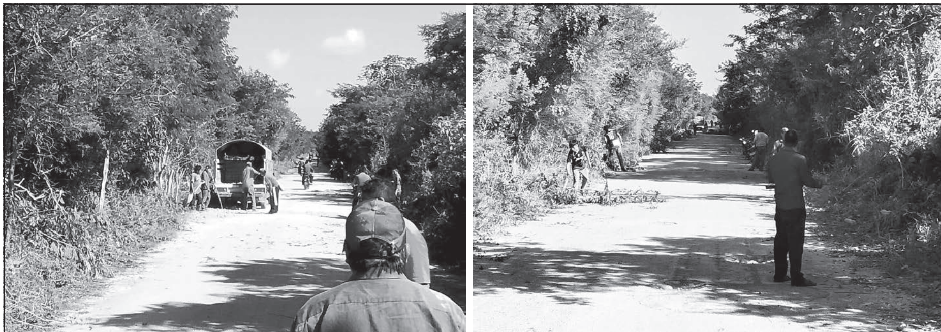
Habitantes de San José Segundo, San Felipe Berriozabal, Cancepché y Trapich colaboraron en el bacheo y limpieza del camino a sus comunidades. (Foto Justino Xiu)
