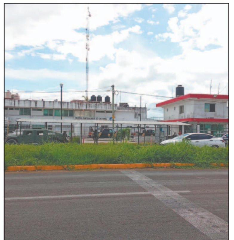
Los reos están purgando condenas por diversos delitos. (PorEsto!)
