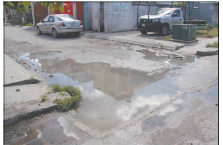
Habitantes de varias zonas están molestos por colapso del drenaje.
