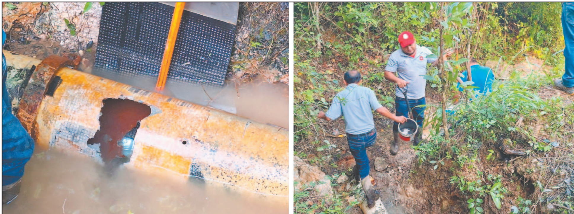
La CAPA paralizó cinco equipos de extracción para llevar a cabo reparaciones en el Pozo 2. Después de las 13:00 horas pusieron en marcha las bombas. (Fotos Justino Xiu)
