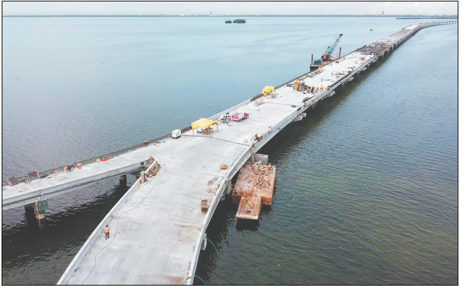
Tres carriles vehiculares, una ciclovía y andadores peatonales forman parte del proyecto que une los bulevares Luis Donald Colosio y Kukulcán. (PorEsto!)
