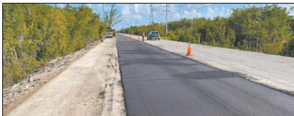
Inconformes dijeron que sólo se firmó el contrato de la vialidad para tomarse la foto.
