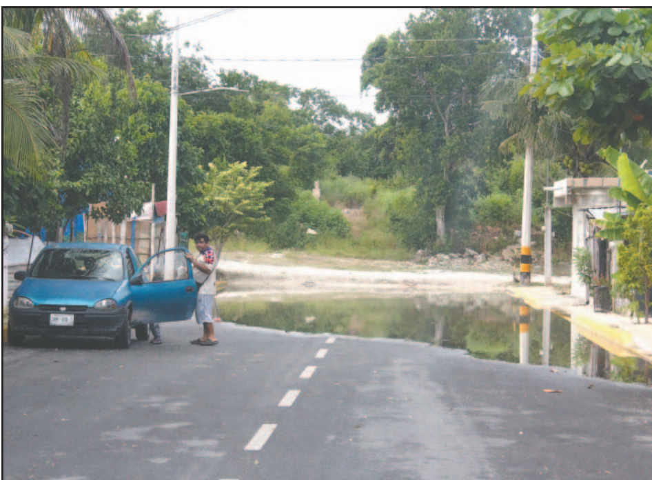
Habitantes manifestaron en vano su malestar a Obras Públicas y Protección Civil.
