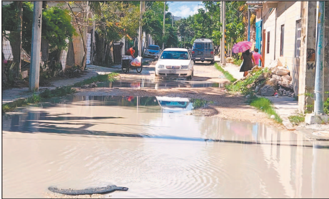
Habitantes dijeron sentirse abandonados, pues el municipio no pavimenta sus vialidades. (Fotos G. Alcocer)
