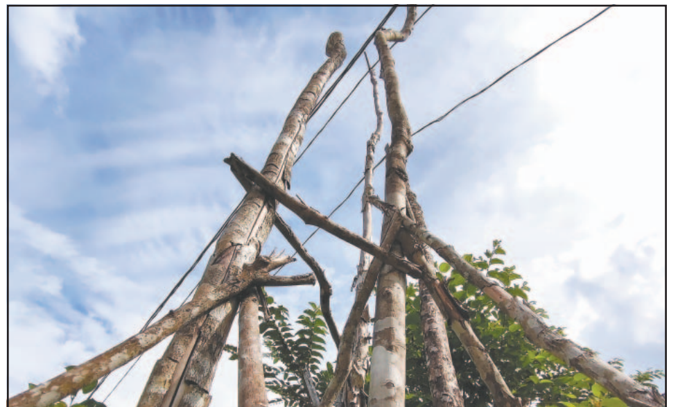
En ocasiones, los menores se suben a los maderos para acomodar los conductos.
