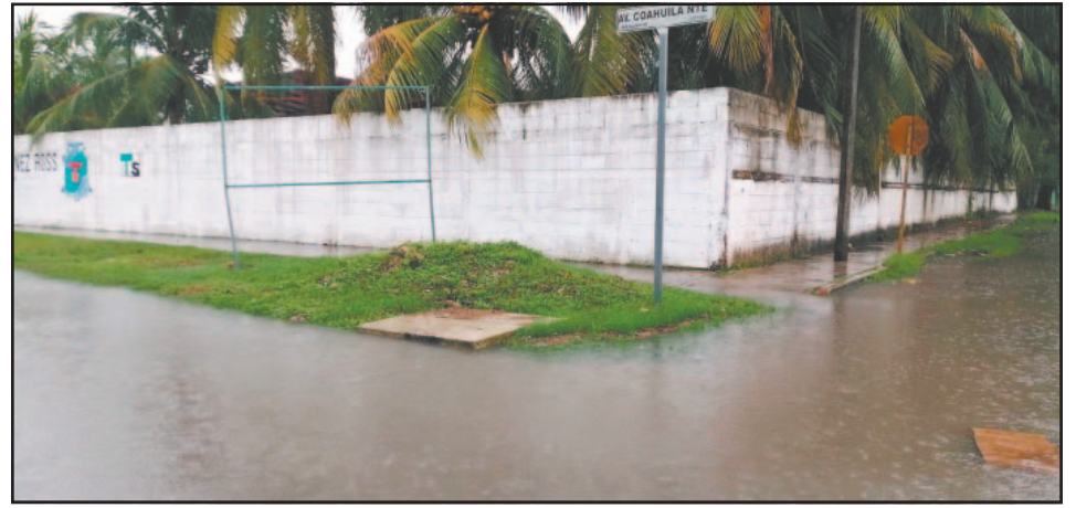
El nivel del agua en la zona baja alcanzó 20 centímetros de altura. (Fotos Williams Duran)
