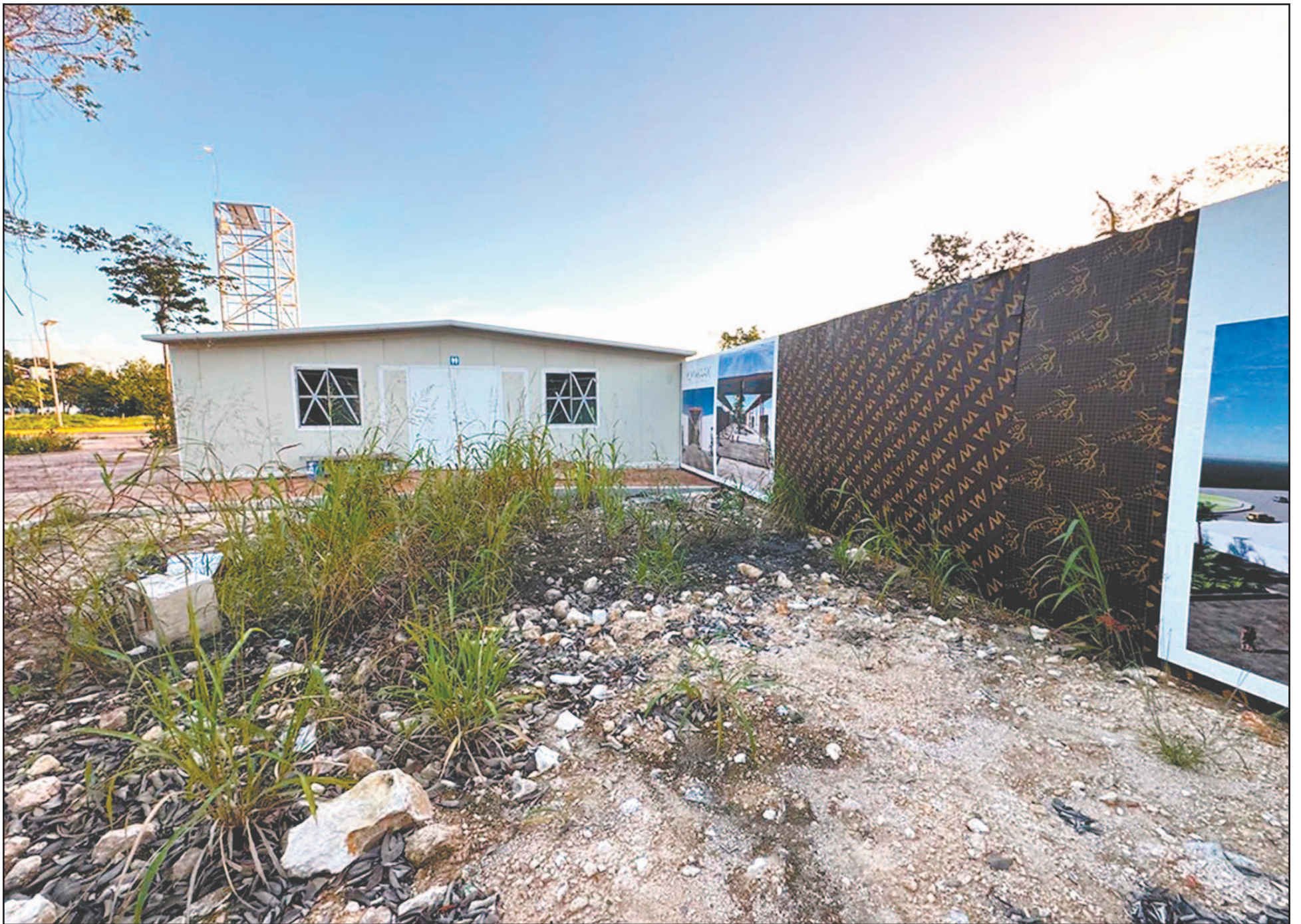
El espacio de 10 mil metros cuadrados, que debía albergar tiendas, cafeterías y productos locales, se deteriora entre maleza y el olvido, sin fecha de conclusión. (Anahí Chamlati)
