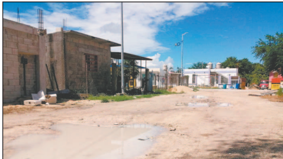
La infraestructura presenta varios cables oxidados, derivado de la salinidad del mar.
