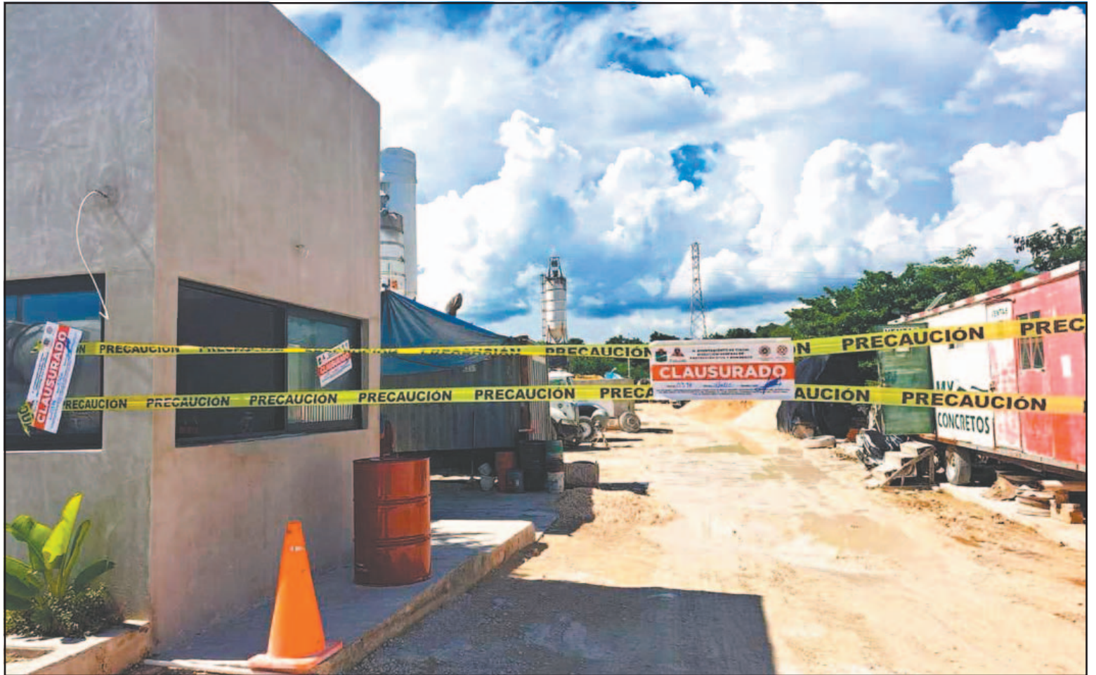
Inspección de Protección Civil encontró incumplimiento en manejo de residuos y riesgo para acuíferos del Caribe Mexicano. (A. Bee)
