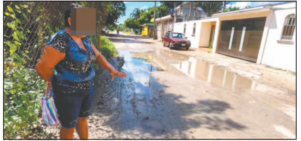
Ciudadanos dijeron que el Ayuntamiento no tiene interés en reparar las vías. (Fotos W. Duran)
