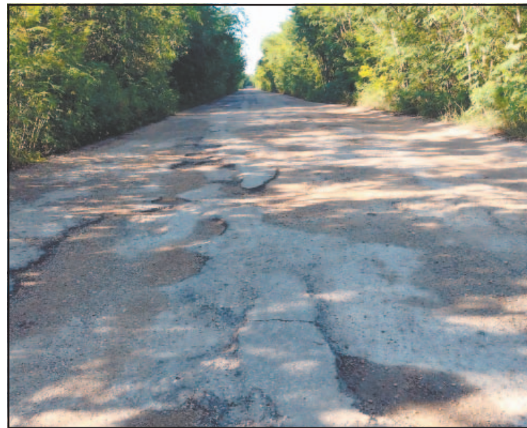
La ruta a Hobompich y Dzoyolá está llena de baches. (Fotos J. Xiu)
