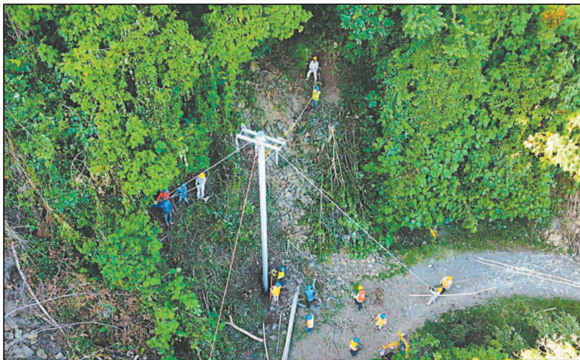
La Comisión indicó que los trabajadores seguirán en las zonas que requieran reparaciones. (POR ESTO!)
