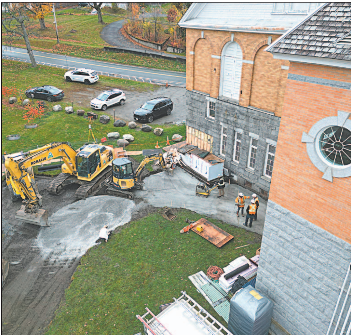
Excavadoras trabajan arduamente en el sitio para devolver la entrada al recinto binacional. (POR ESTO!)
