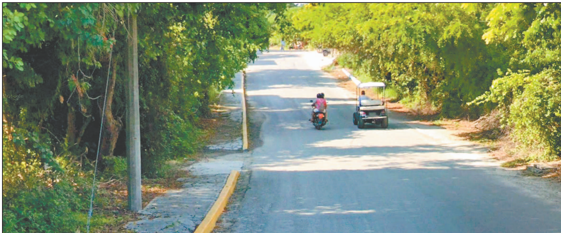
Los pobladores del destino lamentan que las obras prometidas desde hace más de una década sigan inconclusas, afectando la movilidad y seguridad en zonas residenciales. (Ovidio López)
