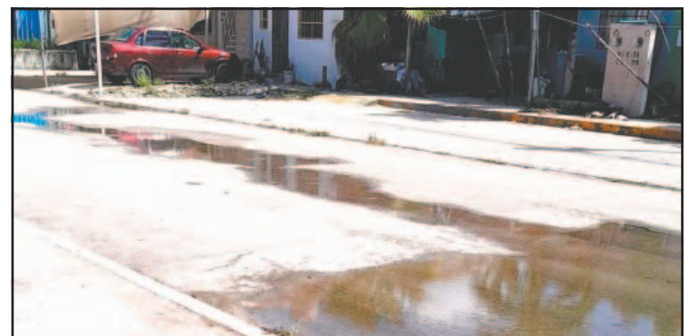
Ciudadanos están hartos de la falta de atención de Aguakan. (PorEsto!)
