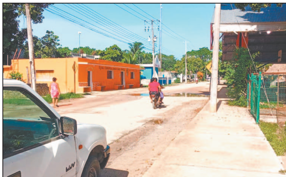
Se especuló que una falla eléctrica fue por la sobrecarga en un transformador. (Fotos E. Cauch)
