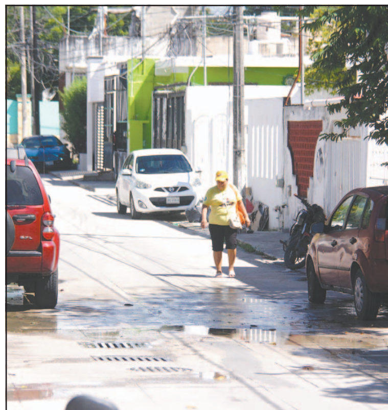
Acusan que no es la primera vez que hay fallas en el drenaje. (H. Breson)
