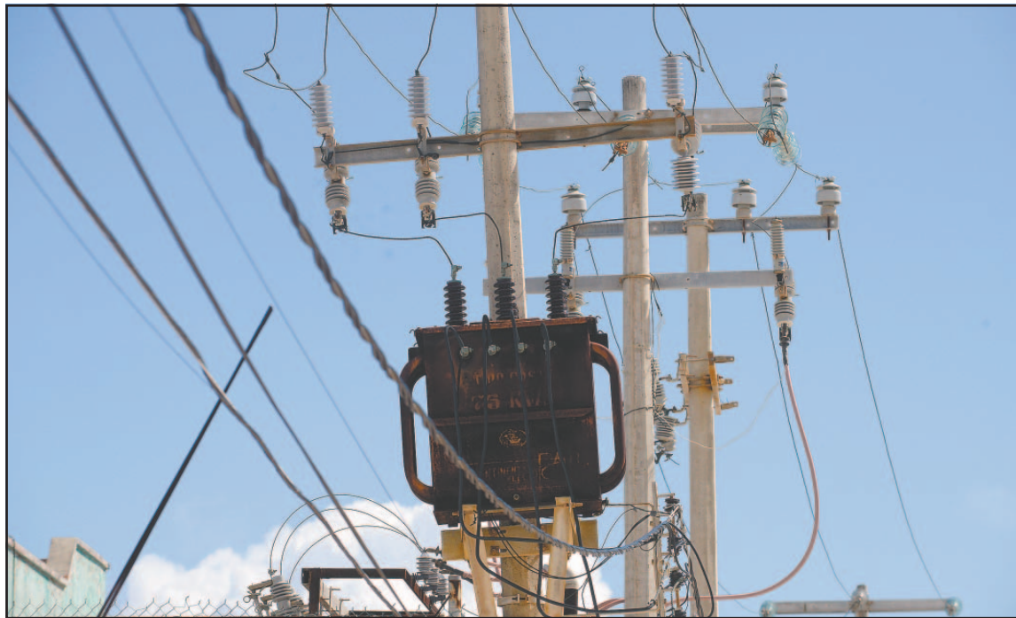
Mientras autoridades presumen modernización, en las colonias los generadores están oxidados.
