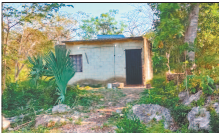
Acusan vecinos que el uso de paneles solares es insuficiente. (E. Cauich)
