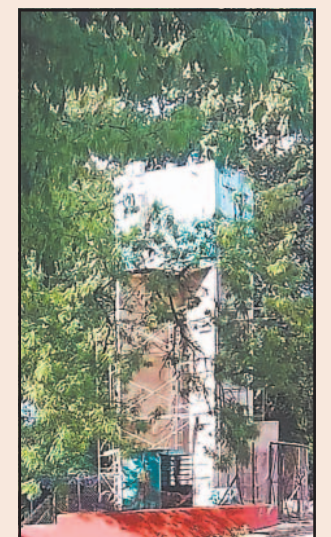
Realizan labores en el tanque elevado del pueblo.
