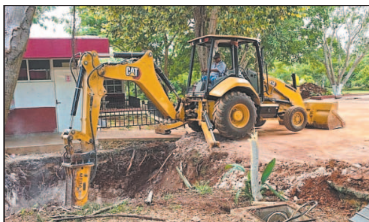
Los trabajos incluyen excavación y conexión al sistema sanitario.
