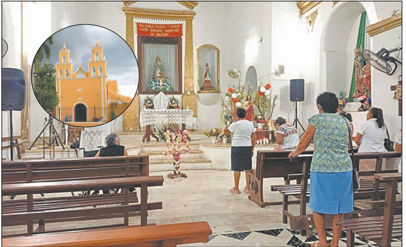
Aunque la comunidad ha realizado reparaciones menores, habitantes solicitan la intervención del INAH para la restauración adecuada.
