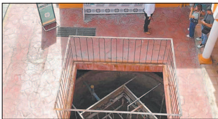
Trabajan en rehabilitación de planta de tratamiento de aguas residuales.
