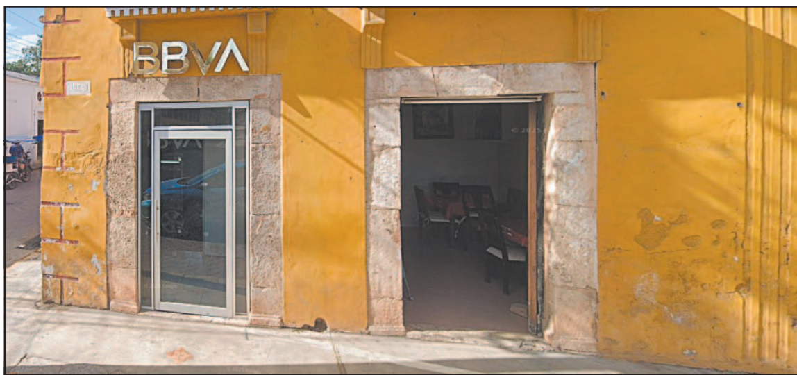
Vecinos expresaron su descontento ante las condiciones de descuido en las que se encuentra el espacio.
